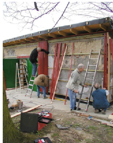
Reparaturarbeiten und Betreuung von Gebäuden
